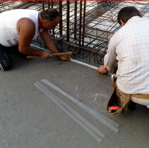
Jaula en red de acero de malla cuadrada, de forma a trapecio abierta por un solo lado, preformada, a utilizar para favorecer el posicionamiento correcto de waterstop en bentonita sódica Clayseal 25.20, y evitar el desplazamiento de la sede prevista, especialmente en situaciones complejas o en superficies no perfectamente implantadas. Bentonet, una vez insertada la junta, deberá ser fijado al soporte en hormigón, mediante grapas de acero y arandelas cada 20-25 cm.
