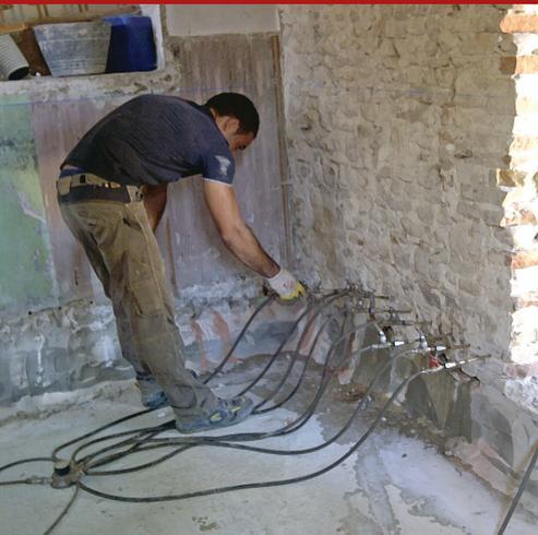
Solución de especiales resinas silicónicas modificadas, dispersas en agua, hidrófilas en fase aplicativa, hidrófugas e hidrorrepelentes tras la reacción con dióxido de carbono atmosférico.
