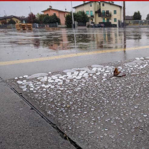
Impregnante repelente al agua y los aceites, incoloro, no pelicular, basado en la nanodispersión de compuestos de silicio. Protege enlucidos a base de cal, morteros de cemento, hormigones, piedras naturales, ladrillo, madera, etc., frente a la intemperie, los ciclos de hielo y deshielo, así como agentes atmosféricos agresivos. No altera el color del sustrato y no modifica la apariencia y la transpirabilidad originales.
