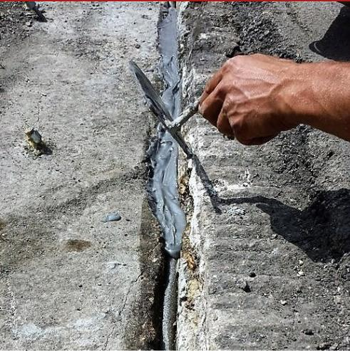
Sellador de epoxi-poliuretano, elastoplástico de dos componentes, tixotrópico, para juntas sujetas a tránsito: dureza Shore A = 65; alargamiento hasta la rotura 70%; para aplicar con llana o extruir en secciones de junta debidamente encintadas (para proteger las superficies adyacentes). Resistente al contacto con hidrocarburos (gasolina y gasóleo).
