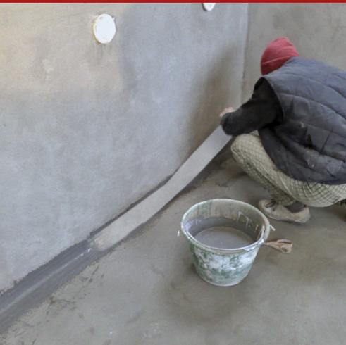
Banda cubrejunta impermeable, constituida por una goma dilatada elastomérica, enteramente revestida en ambos lados de tejido absorbente, de anchura total igual a 12 cm. El producto se distingue por la simple y fácil aplicación, la comprobada estanqueidad al agua y la elevada capacidad de deformación.
