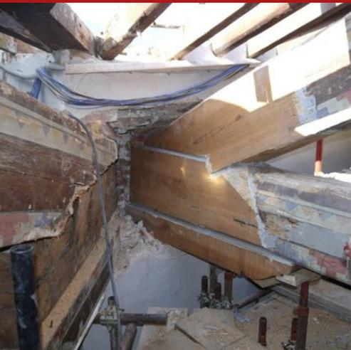
Mortero epoxi formado por un adhesivo epóxico de dos componentes (A+B) para ser integrado con una mezcla de agregados minerales seleccionados con un diámetro máximo de 4 mm, para anclajes, restaurar pisos industriales, regeneración localizada de cabezas de vigas de madera, reparaciones y reconstrucciones de edificios en general, que se llevarán a cabo mediante colada en el sitio, tras la construcción de un encofrado de contención impermeabilizado adecuadamente con agente de liberación.
