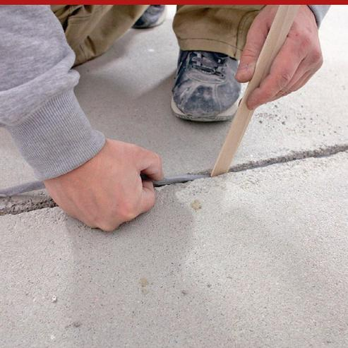
Cordón en polietileno expandido de celdas cerradas, comprimible, para evaluar correctamente la profundidad de las juntas de dilatación (creación de la "tercera pared" o fondo de la junta) antes de ser llenadas con los sellantes poliméricos Protech Flex, PROTECH SIGILFLEX MONO o EG 91. Está disponible en perfiles de sección circular de distinto diámetro que se adaptan a las juntas de cualquier forma y tamaño.
