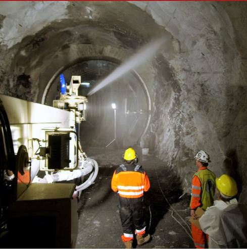
Solución de reactivos minerales (silicatos de sodio) que se utilizará para la aceleración del fraguado de las mezclas y hormigones proyectados, en la consolidación de rocas al aire libre y/o en el túnel, en la construcción de revestimientos de sustento e impermeabilizantes de túneles, canales, aljibes, cuencas, obras subterráneas, etc., a utilizar con equipos especiales para mezclas hidratadas (mezclas en las que el silicato se pulveriza en la boca de salida del spritz-Beton).
