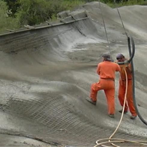
Solución de reactivos minerales, libre de álcalis, utilizada para acelerar el fraguado de lechadas y hormigón proyectado, en la consolidación de rocas al aire libre y/o en túneles, en la construcción de revestimientos autoportantes e impermeabilizantes de túneles, canales, bóvedas, cuencas, obras subterráneas, etc., para ser utilizados tanto en seco como en húmedo directamente en el diseño de la mezcla del hormigón a proyectar.
