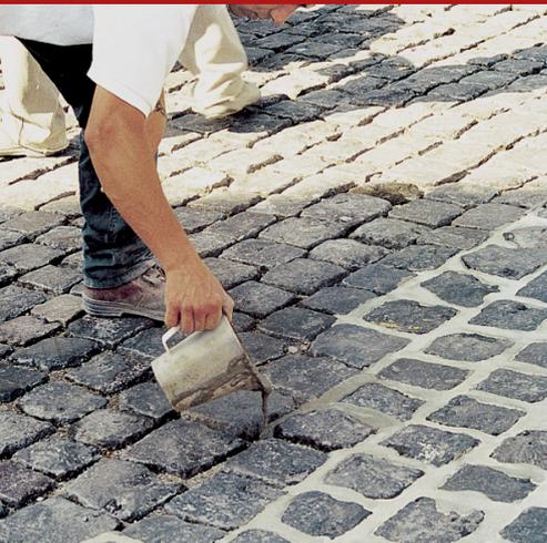
Micomortero de cemento antirretracción, colable, autonivelante, superadhesivo, a base de cementos de alta resistencia, rellenos superpozolánicos, estabilizadores poliméricos, agentes antirretracción. Agregados de calibre máximo de 0,35 mm. Ideal para el relleno de juntas (huecos y/o intersticios) en pavimentos urbanos en pórfido o losas de piedra, incluso de grandes dimensiones. Relleno de grietas y lesiones en estructuras de hormigón y mampostería.
