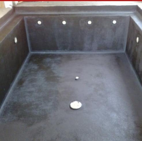
Impermeabilizante cementoso osmótico, monocomponente, reforzado con fibras, polímero modificado, superadhesivo, deformable, con comportamiento plastoelástico. Ideal para impermeabilizar bajo baldosas y proteger el hormigón. Fácil aplicación con llana, brocha o rodillo, tanto en superficies horizontales como verticales. 30 % más de rendimiento que los sistemas de dos componentes.
