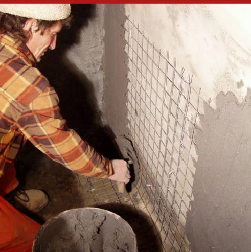
Mortero cementicio, osmótico bicomponente fibroreforzado, a base de conglomerantes hidráulicos, resinas modificadoras y flexibilizantes, filler reactivos superpuzolanicos, para la preparación de mezclas adhesivas, espatulables, que realizan tras endurecimiento, una protección eficaz impermeabilizante, tanto en empuje positivo que en negativo, con elevada capacidad de deformación.
