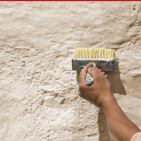
Compuesto osmótico a brocha, a base de cal hidráulica, para la realización de barreras verticales, impermeabilizantes, en obras de muros con estructura porosa (ladrillos, piedras naturales, etc.) en las intervenciones de la bio-construcción, en las nuevas construcciones y reforma de edificios de época y monumentales.
