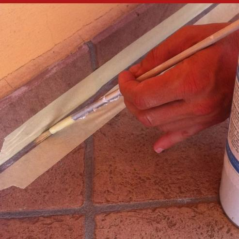
Imprimación de poliuretano que proporciona agarre para la preparación del posterior relleno de juntas con selladores de poliuretano monocomponente en cartucho (Protech Flex o PROTECH SIGILFLEX MONO) o de dos componentes (EG 91) sobre superficies de hormigón y mampostería.
