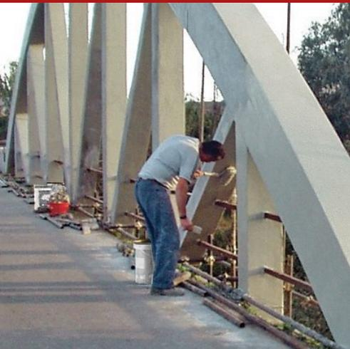
Pintura anticarbonatación, protectora, decorativa, pigmentada para el pintado de superficies de hormigón; a base de resinas acrílicas en emulsión acuosa, forma una película impermeable al agua, con elevada permeabilidad al vapor, anclado por adherencia específica y difusión. Ideal para revestimientos protectores de obras de infraestructura en hormigón.
