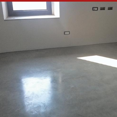
Endurecedor químico-mecánico nanotecnológico, no pelicular, a base de silicatos de litio, para consolidación cortical, endurecimiento químico superficial y tratamiento antipolvo de pavimentos industriales de hormigón de reciente construcción. QL Nano Lithium debe aplicarse sobre la superficie del suelo, inmediatamente después del acabado con allanadora mecánica con aspas. Una vez absorbido el producto, es posible pulir la superficie tratada con las pulidoras adecuadas.
