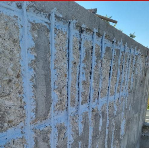
Slurry cementicio monocomponente en polvo, pasivante, de color azul claro, a adicionar con agua, modificado con agentes superpuzolanicos, resinas flexibilizantes y anticorrosión, para el tratamiento pasivante de los hierros de armadura oxidados, en la restauración del hormigón degradado.
