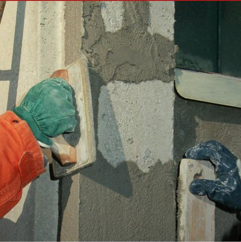
Mortero estructural cementoso, bicomponente, composite, de retracción compensada, reforzado con fibras, a base de cementos de alta resistencia, masillas superpozolánicas, resinas poliméricas dispersas en agua, inhibidores de la corrosión migratoria, aditivos anti-retracción, plastificantes, estabilizantes y anticorrosión agentes, áridos seleccionados, microfibras READYMESH en vidrio, con alto contenido en circonio, y polipropileno multifilamento.
