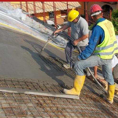
Mortero estructural, tixotrópico, cementoso de altas prestaciones, reforzado con fibra con una mezcla de microfibras metálicas (longitud = 6 mm, diámetro = 0,22 mm) y microfibras sintéticas alcalinorresistentes, utilizado para la restauración y espesamiento de estructuras de hormigón armado y en mampostería, incluso en entornos de exposición severa (marinos, industriales, cíclicamente secos y húmedos).
