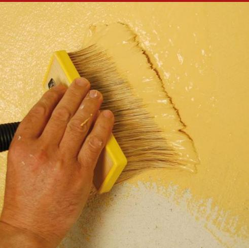
Pintura transpirante, natural, no toxica, para internos y externos, de tipo difusivo, a base de cal hidratada. Formulación a base mineral, activa, de altas capacidades antimoho naturales y anticóndensación, preparada según las recetas de la tradición, para su uso en intervenciones de la bioconstrucción y reforma de edificios de época y monumentales.
