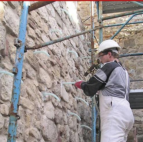
Preparado en polvo, listo para la utilización, a base de cal hidráulica, para la preparación, con la única adición del agua, de lechadas para la consolidación de muros, inyectables y colables, de muy elevadas prestaciones en términos de fluidez, resistencia y estabilidad, en las intervenciones de la bioconstrucción y en la restauración de edificios de época y monumentales.
