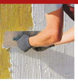
Enlucido adhesivo monocomponente a base de cal hidráulica, polímeros flexibles especiales, aditivos reológicos, retenedores de agua, microsilicatos con actividad puzolánica, áridos esféricos de bajo peso específico. Se utiliza para nivelar enlucidos sobre diversos soportes, encolados ligeros y como enlucido/adhesivo de nuestra membrana especial SANATEX (sobre puentes térmicos, mampostería húmeda y/o deteriorada).
