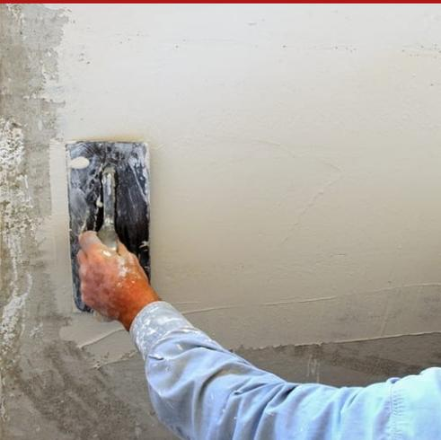
Revestimiento mineral espatulado para internos y externos a los silicatos de potasio de adhesión química, anticondensado, aislante, resistente a los mohos, gracias a la adición de esferas de vidrio cóncavas. De aspecto final similar al revoque civil.
