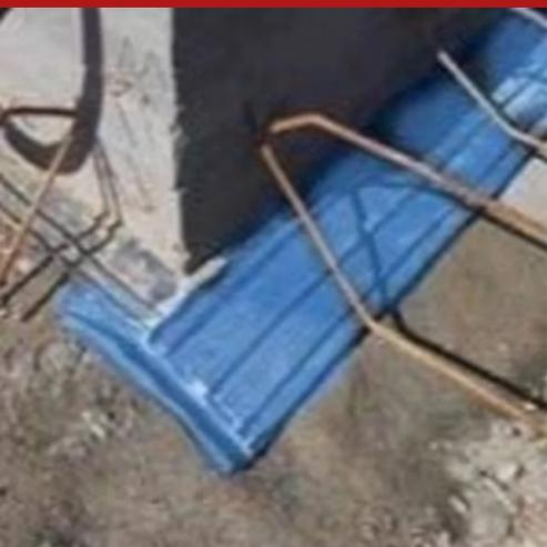
El waterstop SEALPVC RG 250 es un perfil de PVC impermeable, no hidroexpansivo, de 25 cm de ancho, que presenta una elevada elasticidad. Se utiliza en juntas estáticas para coladas horizontales (losas), en estructuras de hormigón, apoyadas sobre el sustrato debajo de la armadura.
