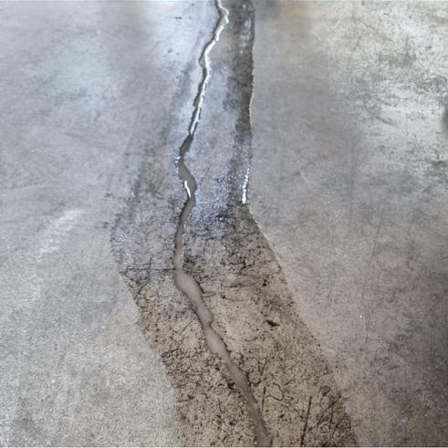
Masilla bicomponente a base de resinas epóxicas de alto contenido en sólidos, utilizable con cargas de cuarzo y/o inertes para la reparación de fisuras en pisos de concreto.
