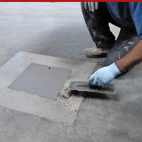
Syntech Grout EP es un mortero epoxi fluido sin disolventes compuesto por resinas epoxi, aditivos específicos y agregados seleccionados de diversa granulometría para trabajos de restauración de estructuras de hormigón armado, suelos de hormigón, construcción de juntas rígidas, anclajes de alta resistencia, anclaje de barras. Se aplica fácilmente mediante simple vertido, llegando a un espesor de hasta 5 mm por capa.
