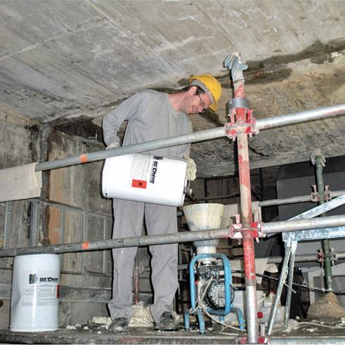
Agente de limpieza específico para las herramientas necesarias durante las operaciones de inyecciones para la paralización de las filtraciones de agua en los edificios. Detergente aceitoso de lavado de baja toxicidad, con elevada capacidad disolvente para poliuretanos no endurecidos, para limpiar y lubricar los circuitos hidráulicos bombeantes internos a las bombas tanto manuales que eléctricas. Sustituye la acetona, el cloruro de metileno y otros detergentes comúnmente utilizados.
