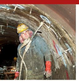
Resina de poliuretano monocomponente, habilitado para el contacto con agua potable, semiflexible, hidroexpansiva (aumenta su volumen inicial de aproximadamente 20 veces), exenta de disolventes, ideal para cerrar herméticamente mediante inyección, pequeñas y grandes filtraciones de agua en hormigón o en albañilerías llenas en general. Ideal para colmar grandes huecos y avisperos internos de la albañilería.
