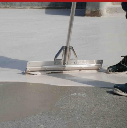
Formulación de tres componentes, a base de resinas epoxi fluidas en emulsión acuosa (A + B) para mezclar con el tercer componente (C), formado por cemento y microcuarzo blancos, especialmente diseñado para su uso como imprimación de superficies cementosas con presencia de humedad y en condiciones de contraempuje hidráulico. Generalmente denominado "Fondos húmedos", es especialmente adecuado como barrera antihumedad para la posterior colocación de parquet.
