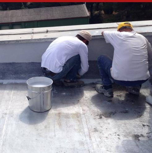
Syntech Poliurea Primer – Pur es una imprimación de poliuretano monocomponente a base de solvente de baja viscosidad, resinas de poliuretano e isocianatos especiales que, una vez aplicada, forma una película elástica que se adhiere al soporte. Es un producto con tiempos de procesamiento de entre 90 y 120 minutos en función del porcentaje de humedad ambiental.
