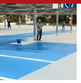
Formulación protectora, pigmentada, de dos componentes, a base de resinas de poliuretano alifático, ideal para el revestimiento protector y estético de impermeabilizaciones realizadas con SYNTECH POLIUREA SPRAY. Se caracteriza por altos niveles de elasticidad y protección, incluso en presencia de atmósferas agresivas. Disponible bajo pedido en las tonalidades de la gama de colores RAL.
