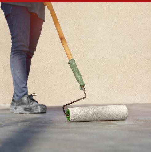
Syntech Primer EP-S es una resina epoxi a base de solvente de dos componentes, específicamente formulada para la impregnación y consolidación de sustratos de porosidad media, incluidos los húmedos. Se aplica sobre conglomerados de cemento, materiales pétreos, madera, etc. preliminares a los ciclos epoxi, poliuretano y metacrílico.
