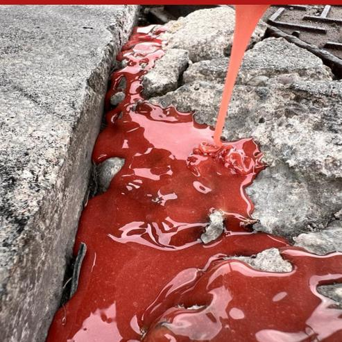
Adhesivo epoxi fluido de viscosidad media para juntas de colada estructural (nuevos conglomerados en construcciones existente); se trata de una formulación de dos componentes que, tras una mezcla cuidadosa, debe aplicarse con brocha o rodillo sobre el hormigón previo, unos minutos antes de la aplicación del nuevo conglomerado ("fresco sobre fresco").
